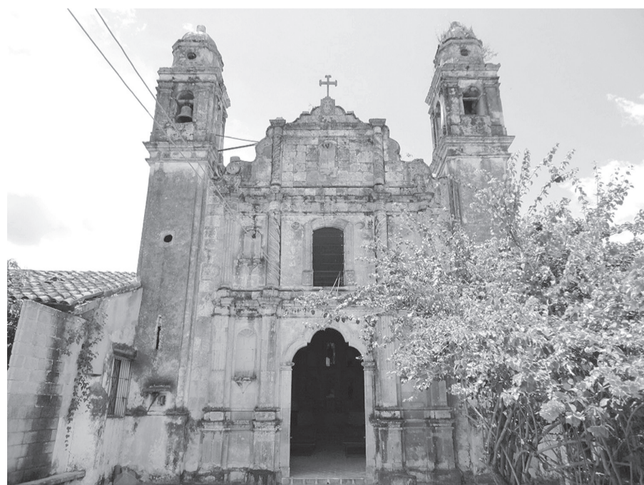
Fachada de la iglesia del Jobo.
