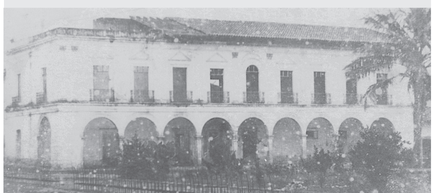
El palacio Municipal acababa de ser incendiado, en 1920, durante el primer mandato como presidente de Wolstano Vernet Cano, a quien le tocó la reconstrucción del mismo.
