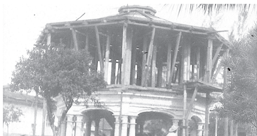
En mayo 15 de 1944, la construcción del kiosco mostraba este avance.
